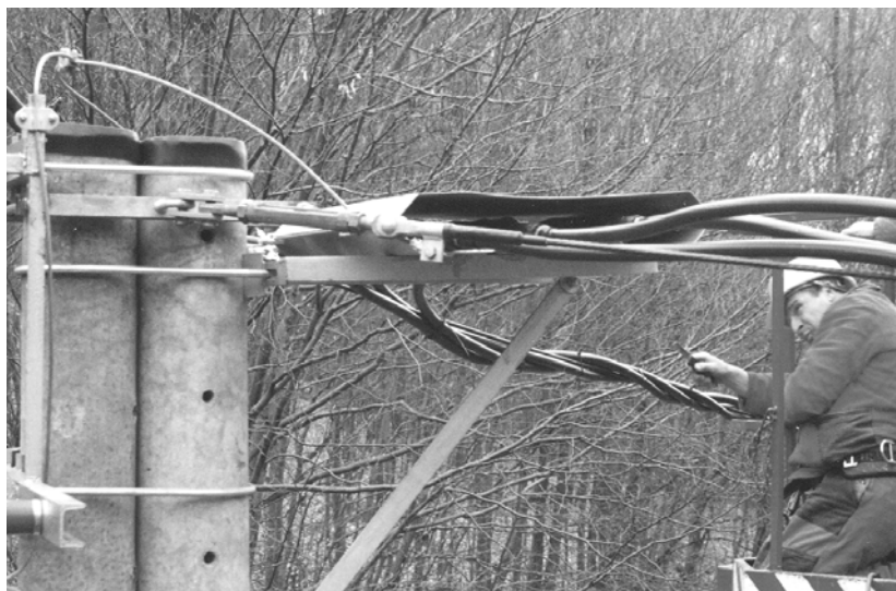
Kotevná svorka A50R+TR, inštalácia 22 kV závesného kábla typ DISTRI
