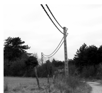
Dva závesné vn káble na jednom stĺpe
