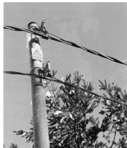
Závesné vn a nn káble na jednom stĺpe
