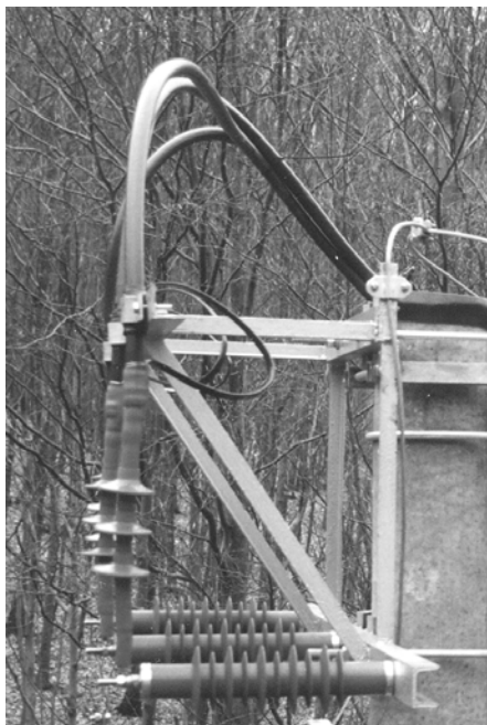
Koncovka POLT na závesnom vn kábli. Koncovka k spínaciemu zariadeniu je montovaná smerom dole – prívod zhora.
