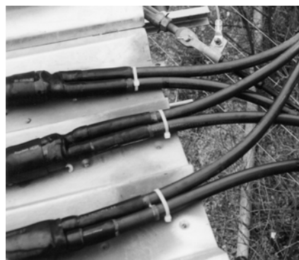
Odbočná spojka závesného vn kábla
