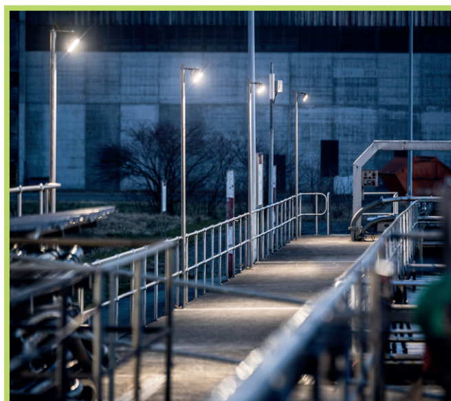
AlphaLUXX – Osvetlenie čističky odpadových vôd
