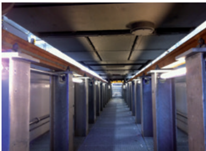
Osvetlenie montážnych jám ÖBB revízia
