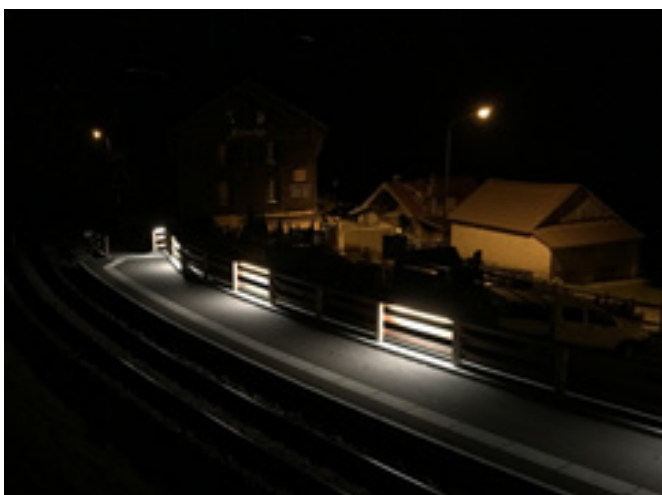
Skúšobná inštalácia Hagerbach mine
